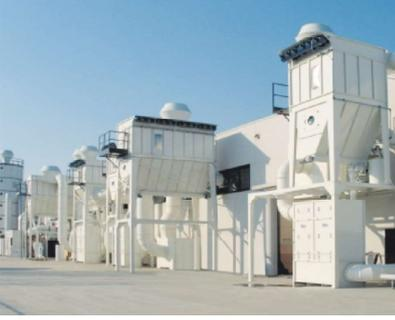
Jet-Pulse basınçlı havayla yıkama özelliği CORAL AIRCOMPACT kartuş filtresi, merkezi bir sızdırmaz ünite içine yerleştirilmiş ve basınç düşürme sistemlerinde kullanılmak üzere tasarlanmış kartuş filtre elemanlarından oluşur. Tozlu hava, haznenin altındaki bölüme girer ve hızdaki keskin düşüş ve çarpma sırasında ön fragmentasyon nedeniyle, en büyük granülometreli parçacıklar toplama haznesinde toplanır.
